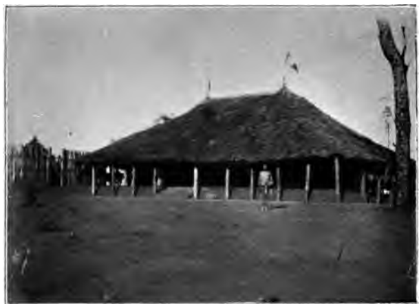
Le poste de Touba terminé.
