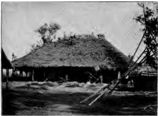
Construction d'un poste.
